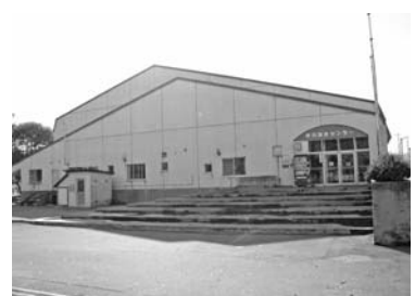
改修を行う海洋センター
