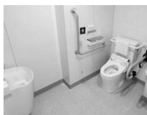
多目的トイレ
