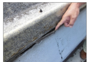
【屋上防水の立上り】
