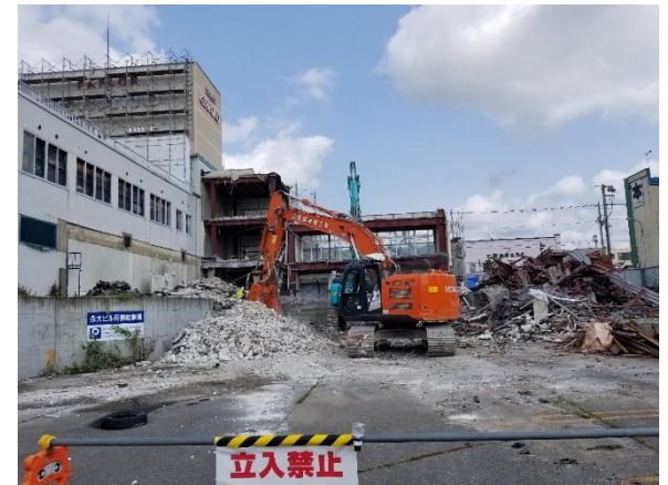
③西側(市道西1条北通り側)
