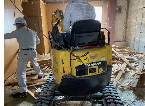
旧SuBACo内部 解体状況
