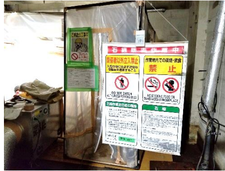
旧パーラーグランド 石綿除去 ※作業開始前
